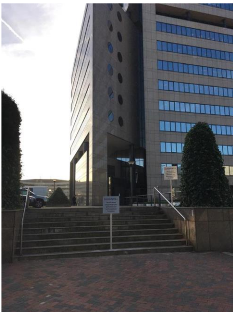
Trapopgang richting kantorencomplex Europlaza. Gezien vanuit het trein-, metro- en busstation Amsterdam Bijlmer Arena.
